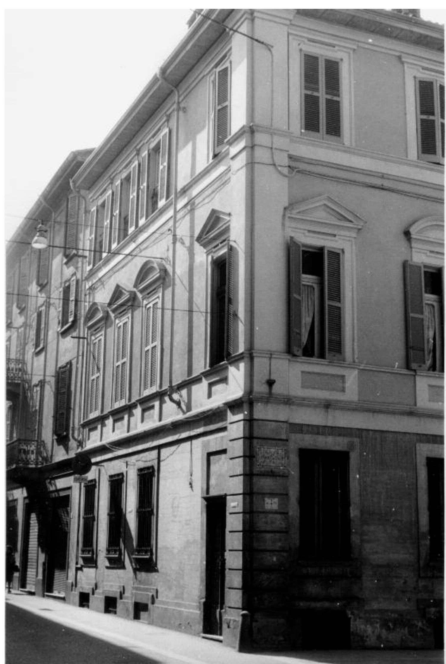
1877. Facciata di palazzo Musso in piazza C. Battisti angolo via Depretis
